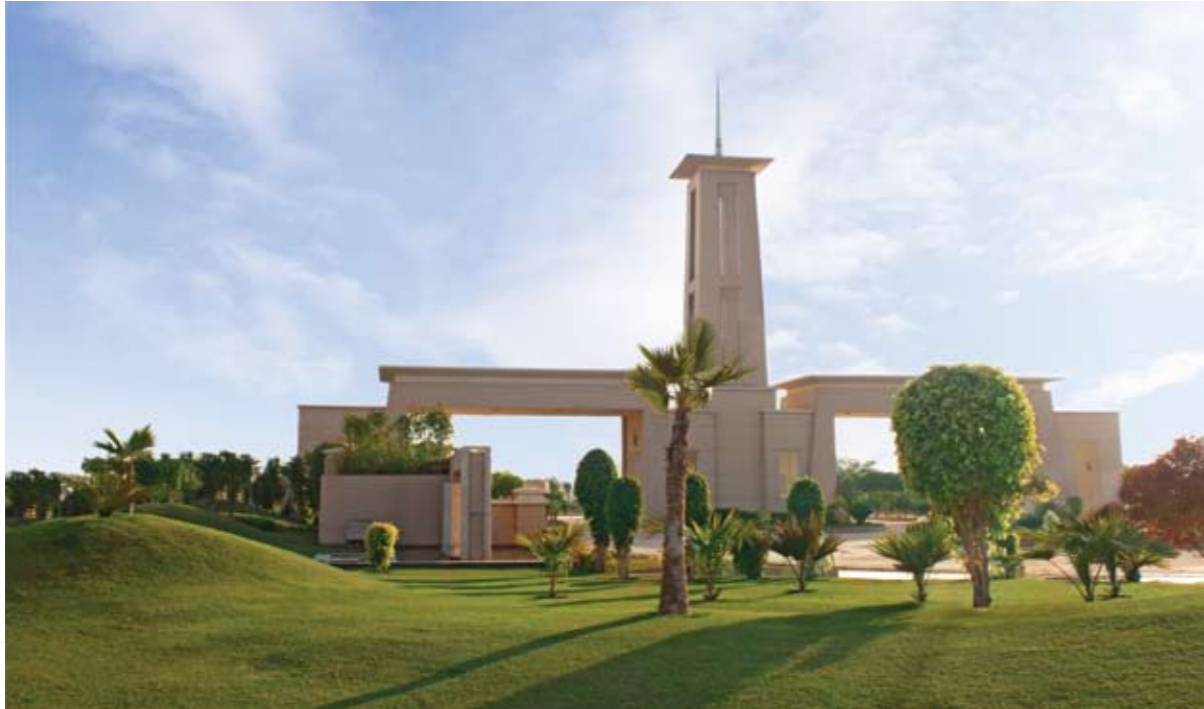
Actual Gate at Emerald Hills
